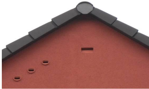
Mauersegler-Nistkästen in der Fassade
